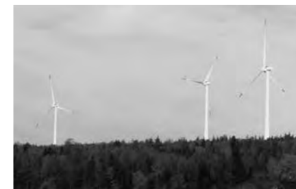
Bild 2: Visualisierung Chroobach Windenergie (Kt. SH, bei Ramsen), chroobach.ch, 4 Anlagen, 200 m hoch, Landverbrauch kleiner 1 ha (0,01 km 2 ), 17 MW, 27–30 GWh/a, Baugesuch eingereicht: 2.7.24.
